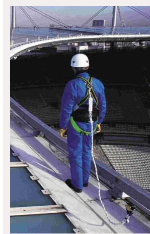
Fig. 6 Longe 4 sur ligne de vie
